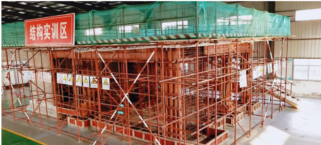
图5 建工实训中心结构实训区主体部分，结合现代BIM信息化手段，按照建筑工地真实施工作业场景1:1打造，满足施工技术课程教学实训要求。
